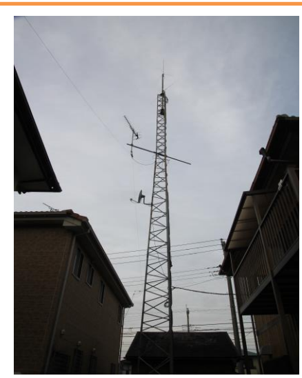
FBなアンテナタワー
